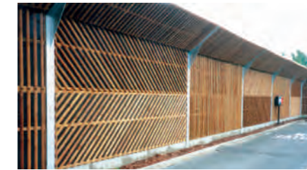
Lärmschutzwand an Parkplatzzufahrt
