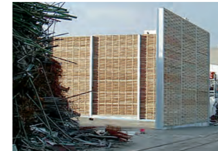
Lärmschutzwand an Recyclingbetrieb
