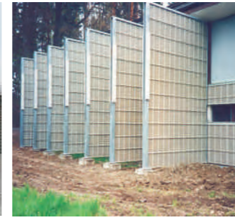
Lärmschutzwand an einer Schießanlage
