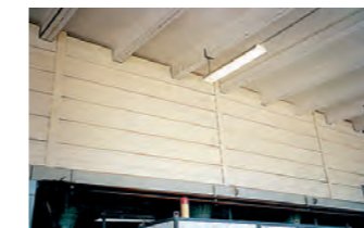
Lärmschutzwand auf Granulatbühne
