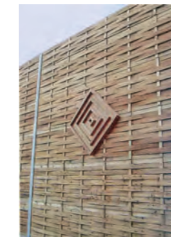
Lärmschutzwand mit Ornament
