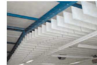
Deckenabsorber in einer Fertigungshalle
