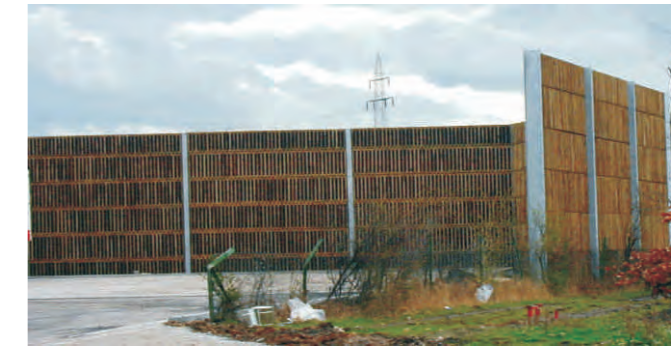
Lärmschutzwand bei einem Logistikbetrieb
