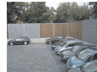
Lärmschutzwand an einem Parkplatz
