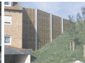
Lärmschutzwand an einer Wohnbebauung
