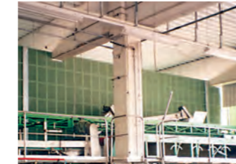
Lärmschutzwand in Lebensmittelbetrieb
