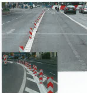
Leitschwelle/ Guide barrier
