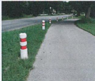
Zur Geh- und Radwegabtrennung bzw. Fahrbahnabtrennung
