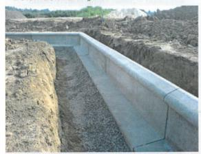
Diese Beton-Leitwand erfüllt die technischen MAmS Kriterien, ist formstabil, standsicher und frost-/tausalz beständig.
