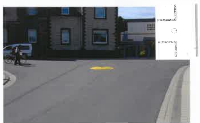
Beruhigungsinsel an einer Straßeneinmündung Soft speed reducer on a street junction
