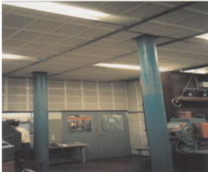
Lärmschutzwand in Fertigungshalle
