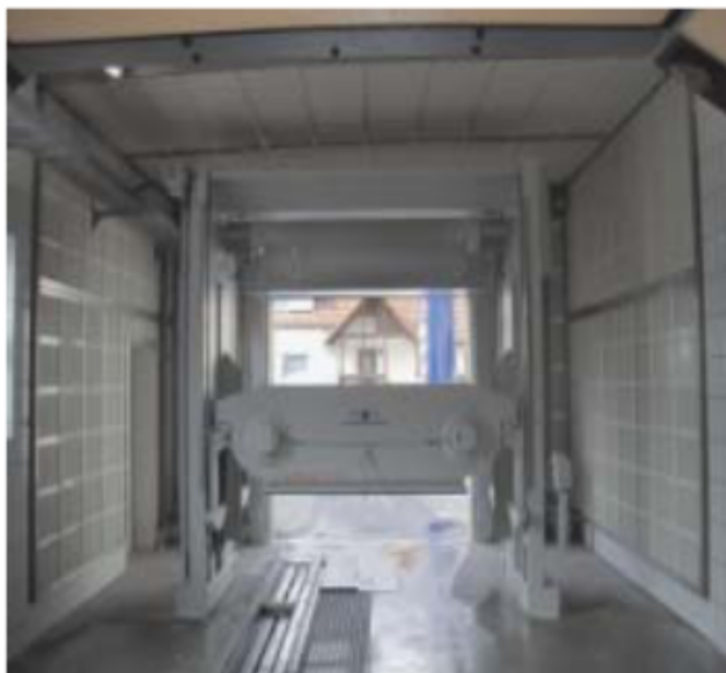
Lärmschutzverkleidung in Waschhalle
