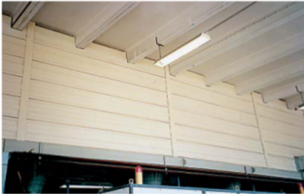
Lärmschutzwand auf Granulatbühne
