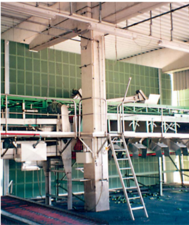
Lärmschutzwand in Lebensmittelbetrieb
