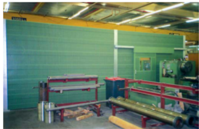
Lärmschutztrennwand in Fertigungsbetrieb
