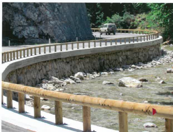
2 Meter - Pfostenabstand mit Fußplatte
