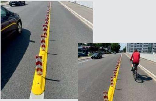
Die temporäre Lösung durch einfaches Auflegen, auch ohne verschrauben möglich.
